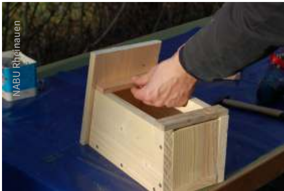
9. Obere Leiste durch Anlegen des Dachs anpassen.
