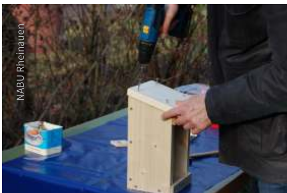
13. Das Dach festschrauben.
